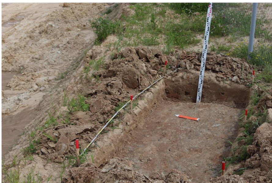
Рис. 52 2021 г. Земельные участки с кадастровыми номерами 40:12:070101:397, 40:12:070101:163, расположенные по адресу: Калужская область, Людиновский район, вблизи д. Войлово. Шурф 7. Вид с юго-запада.
