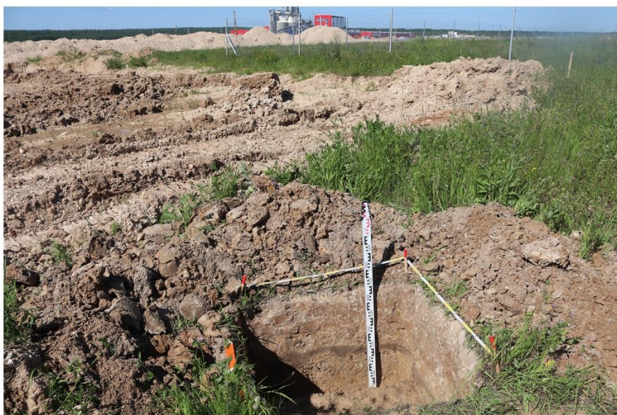
Рис. 69 2021 г. Земельные участки с кадастровыми номерами 40:12:070101:397, 40:12:070101:163, расположенные по адресу: Калужская область, Людиновский район, вблизи д. Войлово. Шурф 11. Вид с юго-запада.
