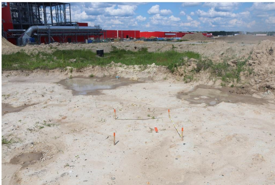
Рис. 25 2021 г. Земельные участки с кадастровыми номерами 40:12:070101:397, 40:12:070101:163, расположенные по адресу: Калужская область, Людиновский район, вблизи д. Войлово. Местоположение шурфа 4. Вид с юга.
