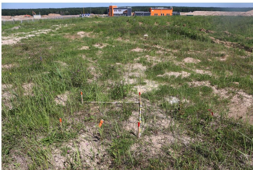
Рис. 101 2021 г. Земельные участки с кадастровыми номерами 40:12:070101:397, 40:12:070101:163, расположенные по адресу: Калужская область, Людиновский район, вблизи д. Войлово. Местоположение шурфа 18. Вид с юга.
