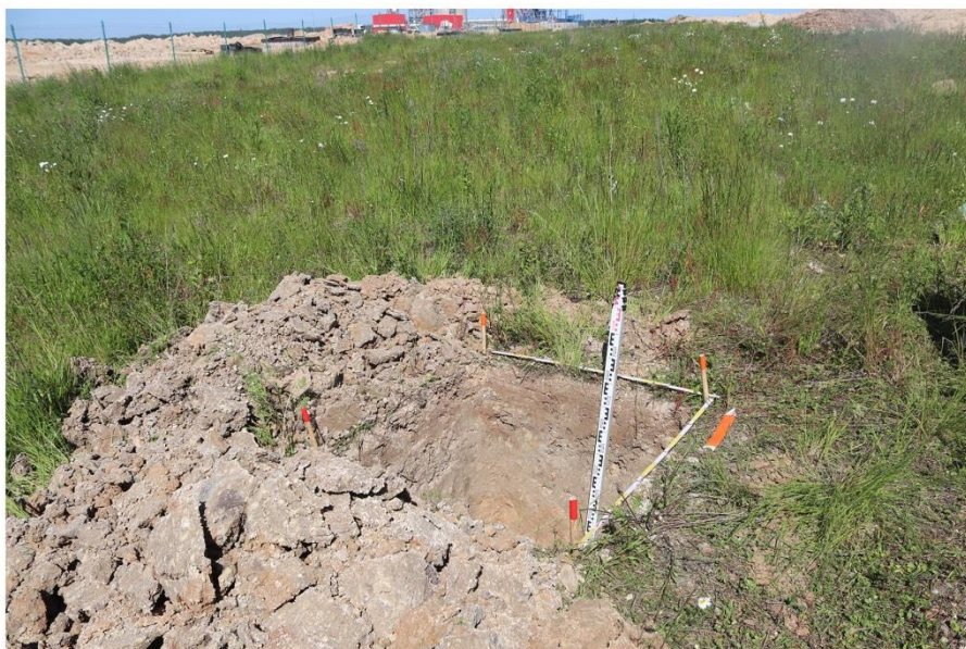
Рис. 121 2021 г. Земельные участки с кадастровыми номерами 40:12:070101:397, 40:12:070101:163, расположенные по адресу: Калужская область, Людиновский район, вблизи д. Войлово. Шурф 21. Вид с юго-запада.
