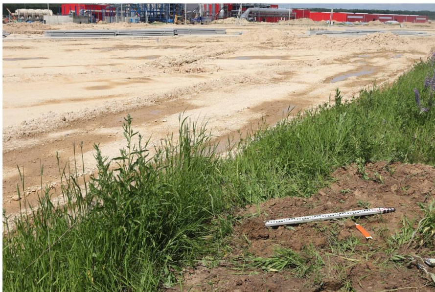
Рис. 62 2021 г. Земельные участки с кадастровыми номерами 40:12:070101:397, 40:12:070101:163, расположенные по адресу: Калужская область, Людиновский район, вблизи д. Войлово. Фото засыпанного шурфа 9. Вид с юго-запада.
