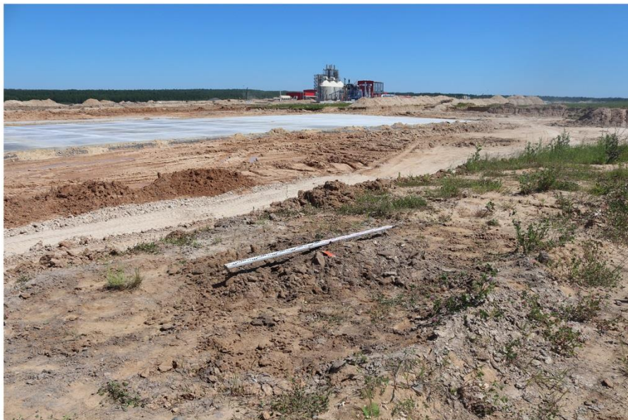
Рис. 92 2021 г. Земельные участки с кадастровыми номерами 40:12:070101:397, 40:12:070101:163, расположенные по адресу: Калужская область, Людиновский район, вблизи д. Войлово. Фото засыпанного шурфа 16. Вид с юго-запада.
