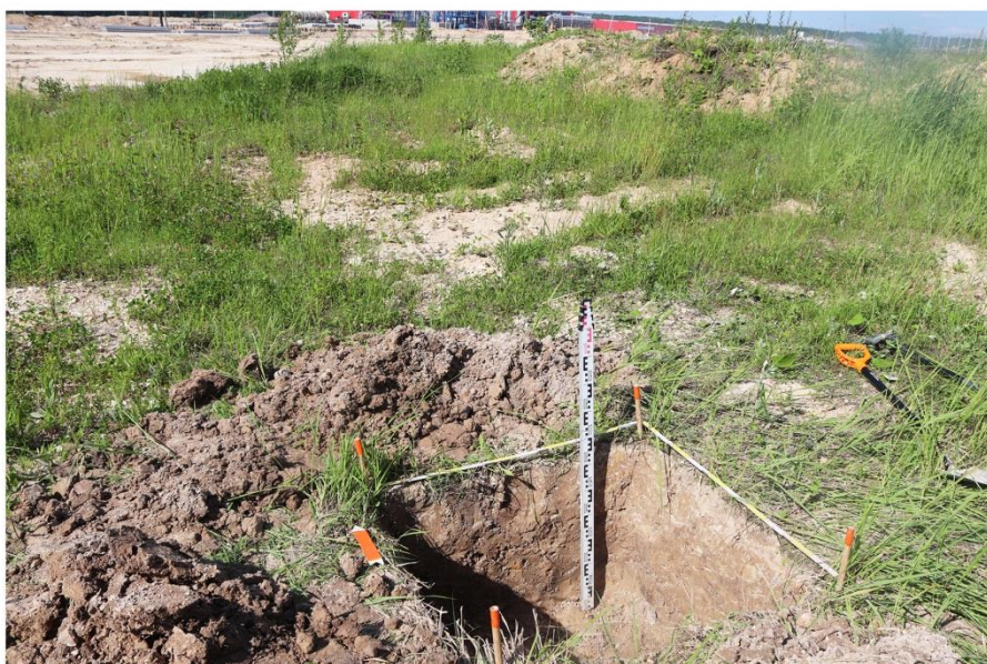
Рис. 73 2021 г. Земельные участки с кадастровыми номерами 40:12:070101:397, 40:12:070101:163, расположенные по адресу: Калужская область, Людиновский район, вблизи д. Войлово. Шурф 12. Вид с юго-запада.
