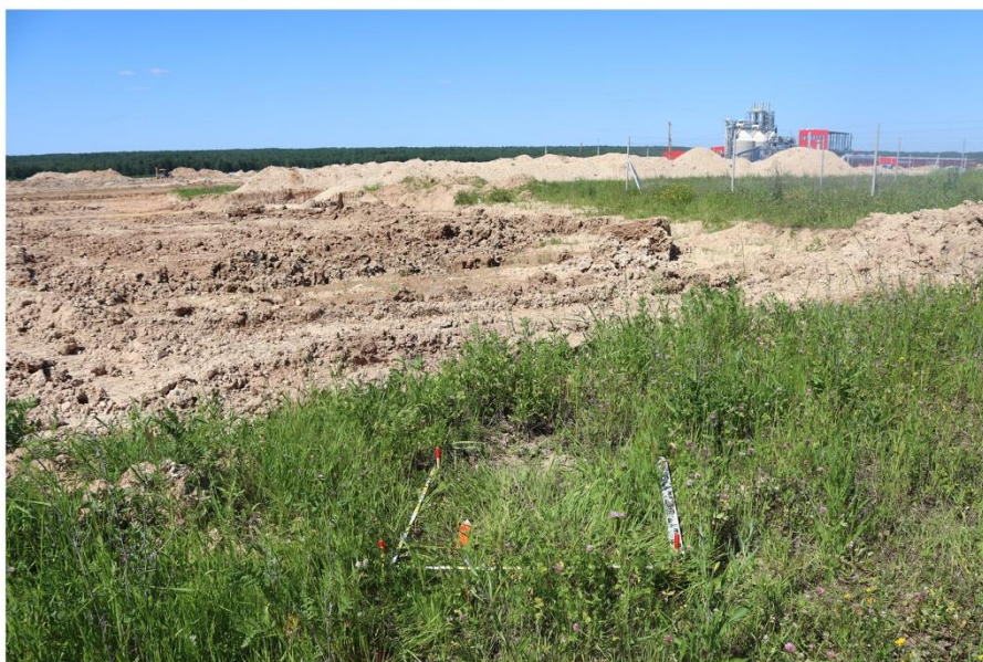
Рис. 68 2021 г. Земельные участки с кадастровыми номерами 40:12:070101:397, 40:12:070101:163, расположенные по адресу: Калужская область, Людиновский район, вблизи д. Войлово. Местоположение шурфа 11. Вид с юга.
