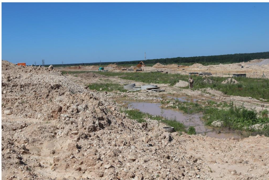
Рис. 116 2021 г. Земельные участки с кадастровыми номерами 40:12:070101:397, 40:12:070101:163, расположенные по адресу: Калужская область, Людиновский район, вблизи д. Войлово. Фото общего вида северной части обследованной территории. Вид с востока.
