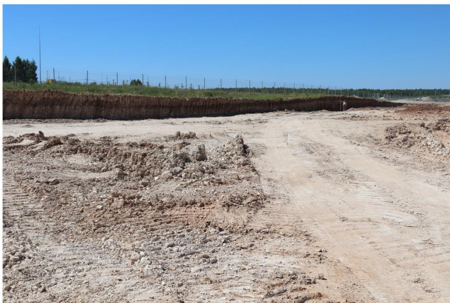
Рис. 42 2021 г. Земельные участки с кадастровыми номерами 40:12:070101:397, 40:12:070101:163, расположенные по адресу: Калужская область, Людиновский район, вблизи д. Войлово. Фото общего вида южной части обследованной территории. Вид с северо-востока.
