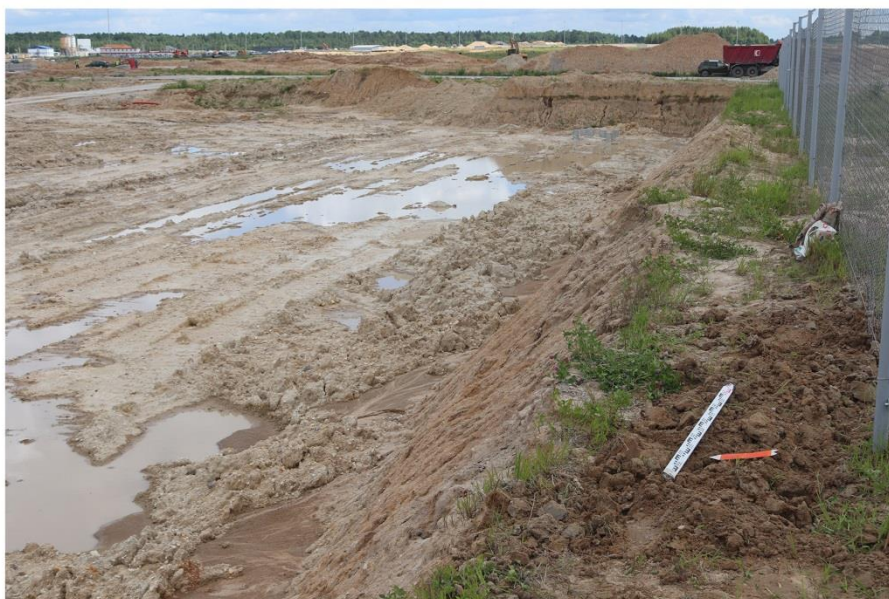
Рис. 49 2021 г. Земельные участки с кадастровыми номерами 40:12:070101:397, 40:12:070101:163, расположенные по адресу: Калужская область, Людиновский район, вблизи д. Войлово. Фото засыпанного шурфа 6. Вид с запада.
