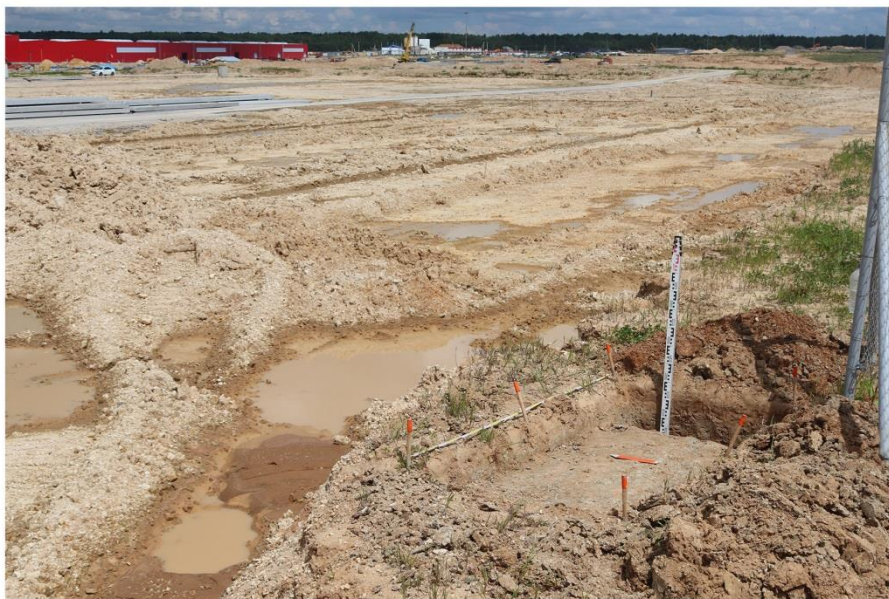
Рис. 56 2021 г. Земельные участки с кадастровыми номерами 40:12:070101:397, 40:12:070101:163, расположенные по адресу: Калужская область, Людиновский район, вблизи д. Войлово. Шурф 8. Вид с юго-запада.
