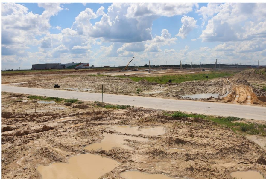
Рис. 119 2021 г. Земельные участки с кадастровыми номерами 40:12:070101:397, 40:12:070101:163, расположенные по адресу: Калужская область, Людиновский район, вблизи д. Войлово. Фото общего вида центральной и северной частей обследованной территории. Вид с северо-востока.
